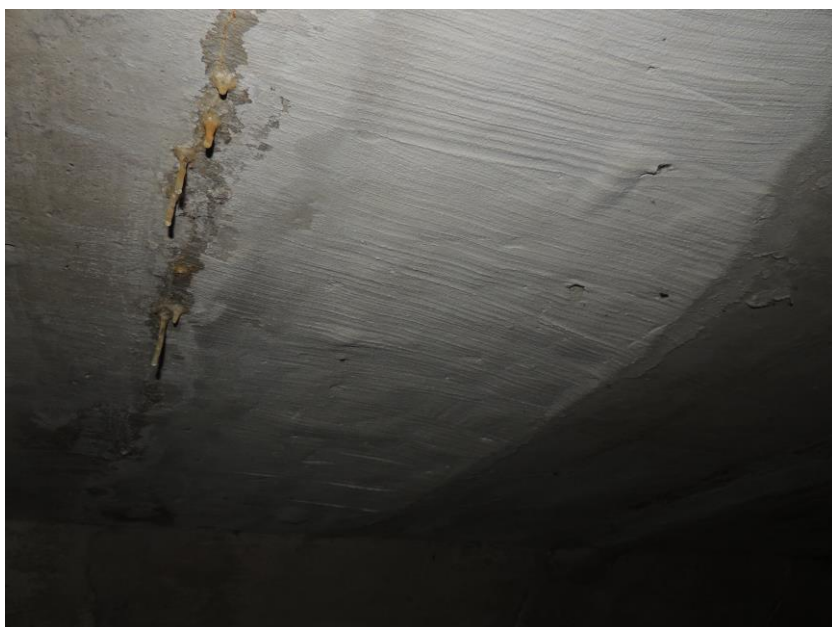
Původní výspravy stropních částí prefabrikovaných rámu a vápenné inkrustace v místě spáry mezi prefabrikáty
