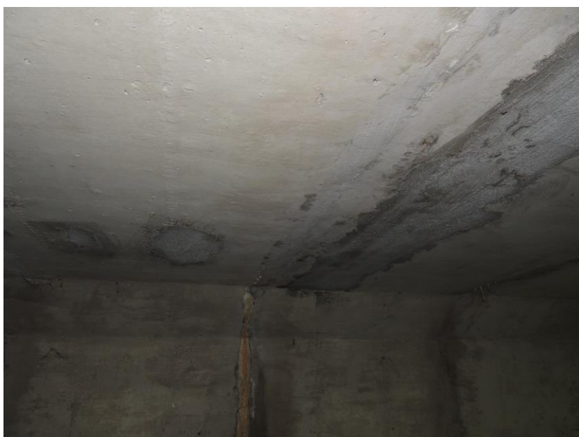
Původní výspravy stropních částí prefabrikovaných rámu mostu a protékající spára mezi prefabrikáty
