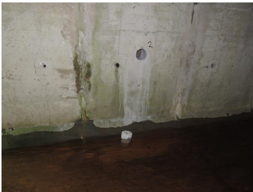
Místo odběru vzorku číslo 2 pro stanovení pevnosti betonu prefabrikátu
