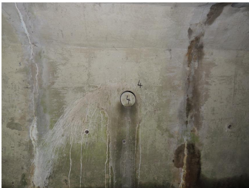
Místo odběru vzorku číslo 4 pro stanovení pevnosti betonu prefabrikátu
