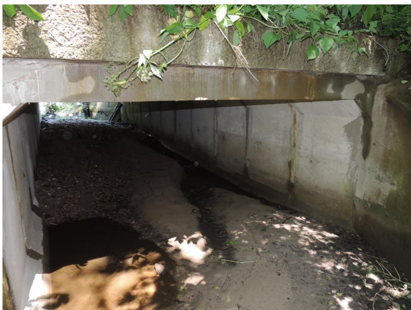
Vlhké stopy na bočním líci prefabrikátu pod římsou mostu
