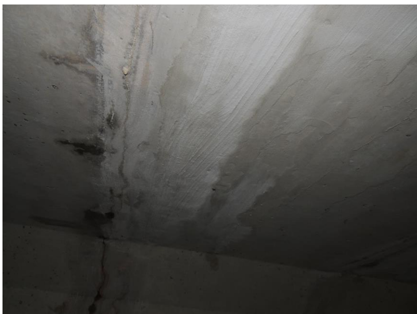
Původní výsrava stropní části prefabrikátu
