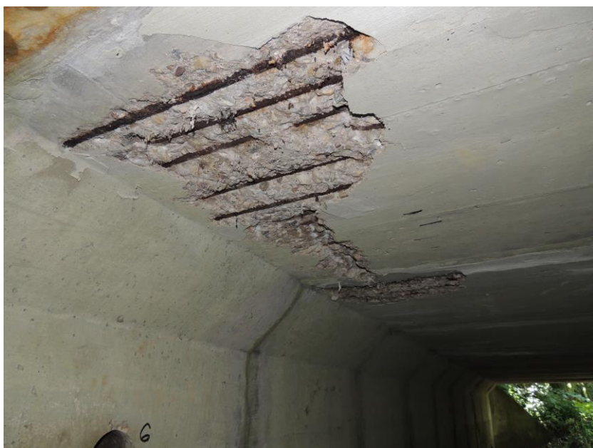
Pohled na plošnou sondu k výztuži stropní části prefabrikátu
