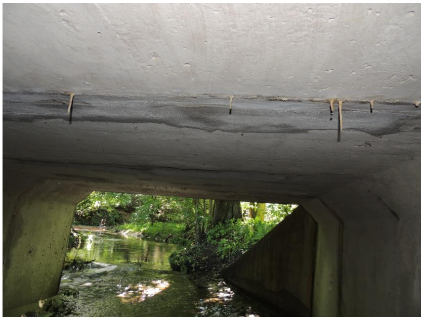
Vápenné inkrustace v místě stykové spáry mezi prefabrikovanými rámy mostu
