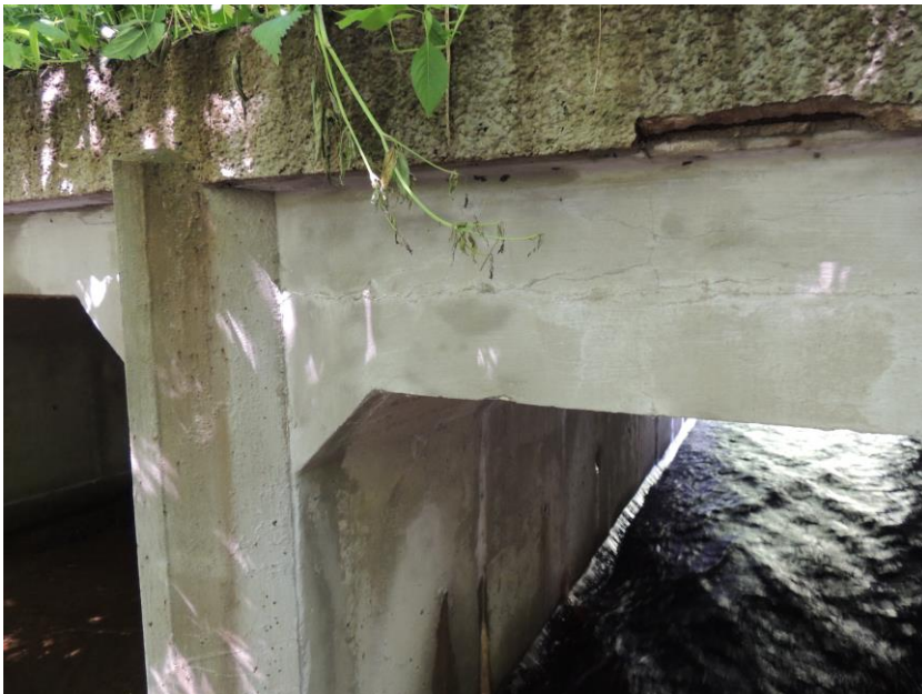
Pohled na opevňovací stěnu mezi poli mostu na vtokové straně
