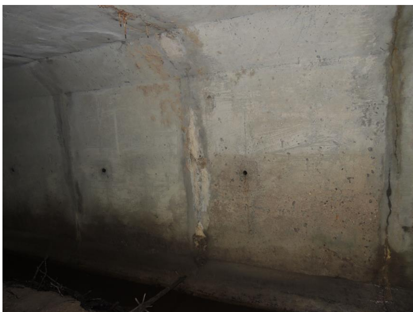
Vápenné inkrustace na povrchu stykové spáry mezi prefabrikáty
