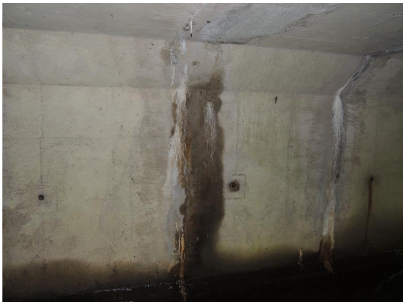
Stopy po vytékající vodě ze stěny prefabrikátu a vápenné inkrustace na povrchu stykové spáry mezi prefabrikáty
