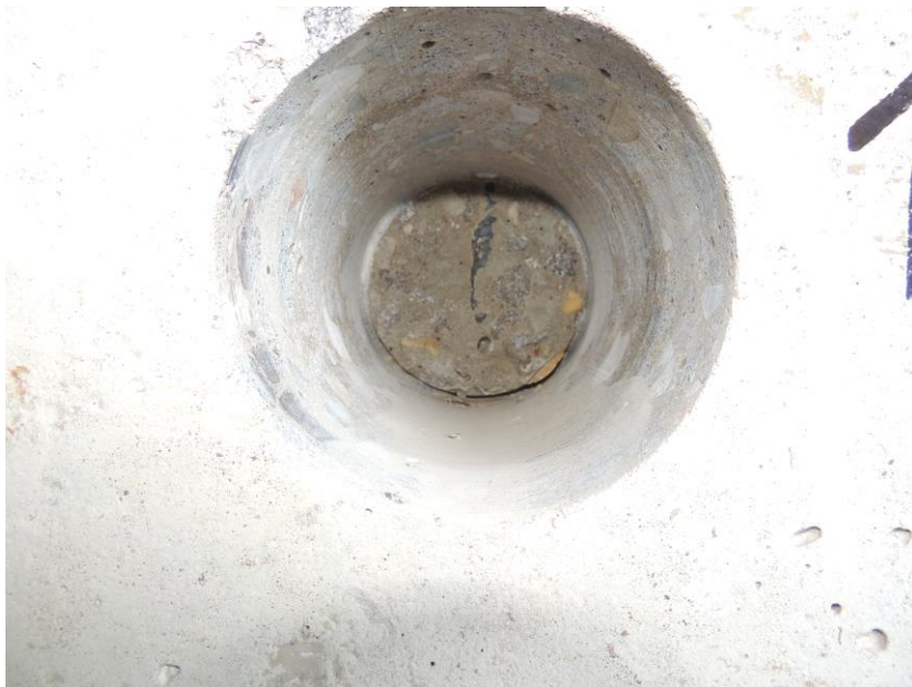
Pohled do otvoru po odběru vzorku, viditelná výztuž vnější části stěny prefabrikátu
