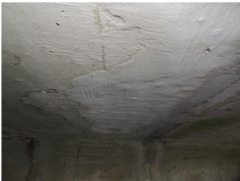
Původní výspravy stropních částí prefabrikovaných rámců mostu
