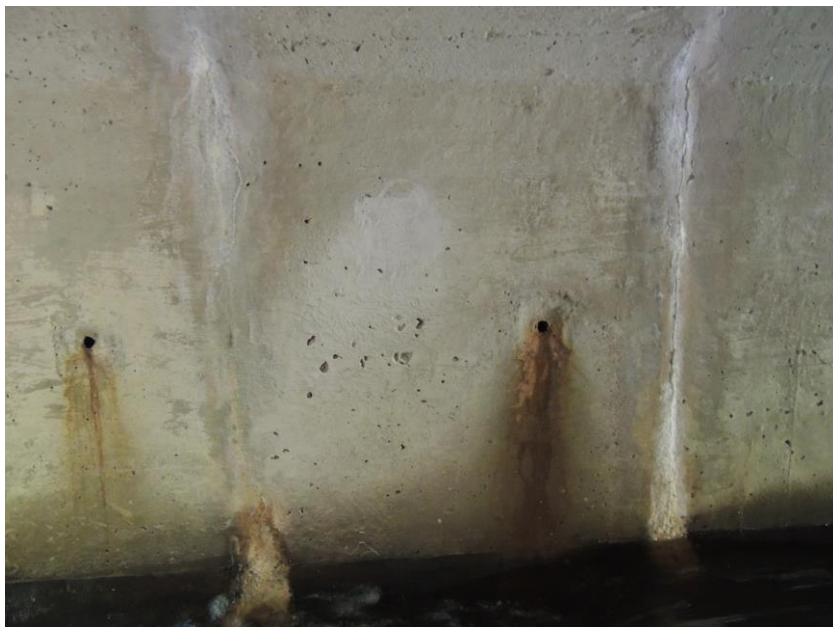
Stopy po vytékající vodě z otvorů ve stěnách prefabrikátů a vápenné inkrustace na povrchu stykové spáry mezi prefabrikáty
