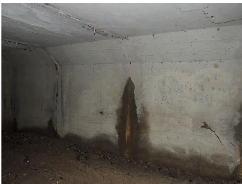
Vápenné inkrustace na povrchu stykových spár a stopy po vytékající vodě na povrchu stykové spáry mezi prefabrikáty
