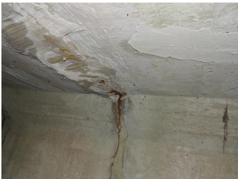
Původní výspravy stropních částí prefabrikovaných rámců mostu a protékající spára mezi prefabrikáty
