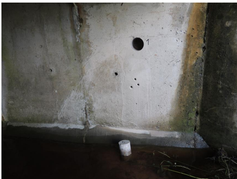
Místo odběru vzorku číslo 1 pro stanovení pevnosti betonu prefabrikátu
