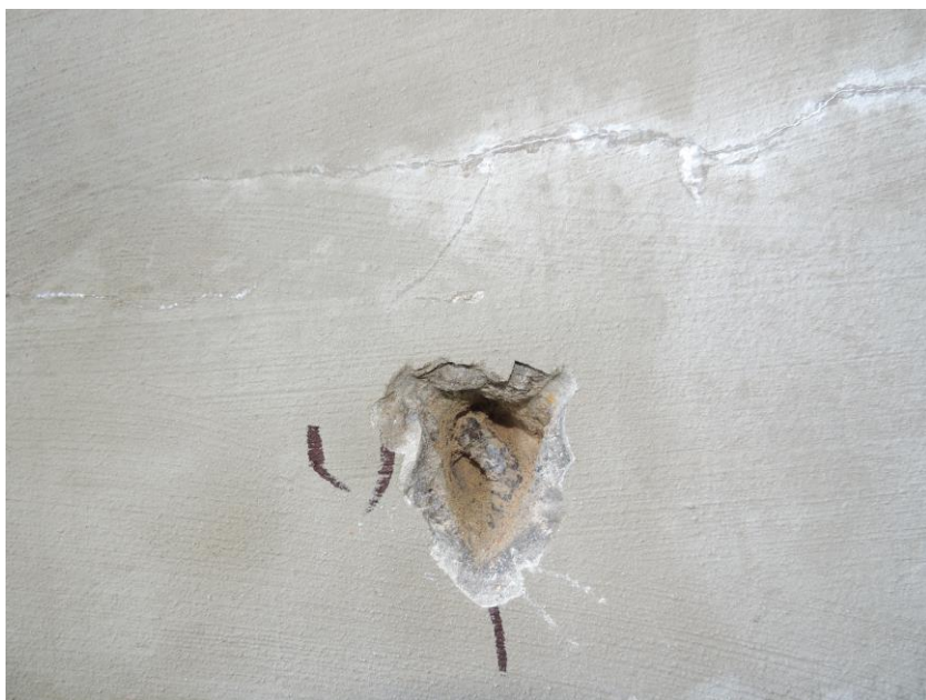
Sonda k příčné výztuži prefabrikátu z bočního líce
