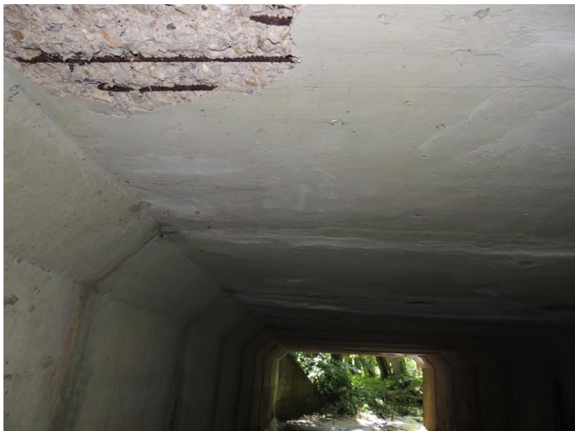
Pohled na trhliny na stropních částech prefabrikátů od korodující výztuže
