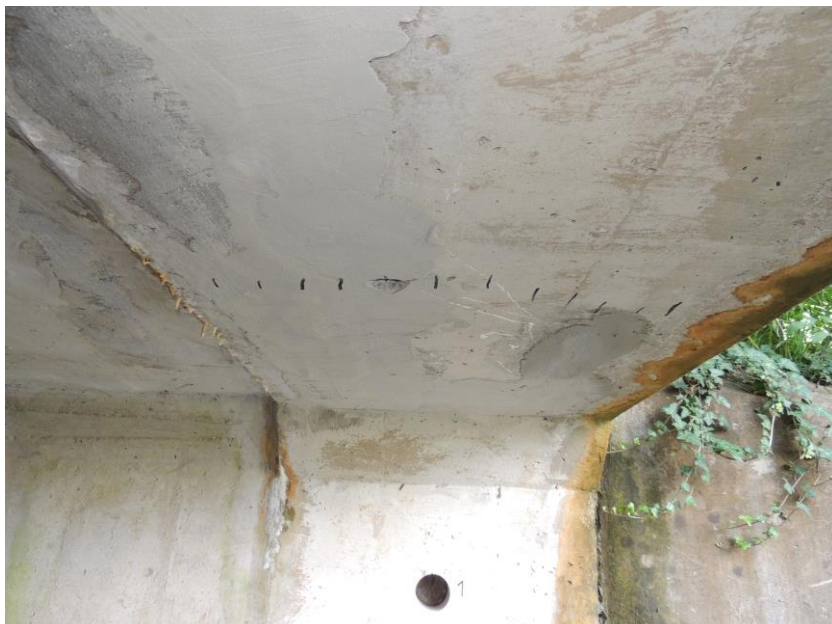
Nalezená výztuž stropní části prefabrikovaného Benešova rámu
