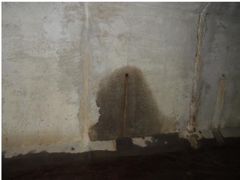
Stopy po vytékající vodě z otvoru ve stěně prefabrikovaného Benešova rámu
