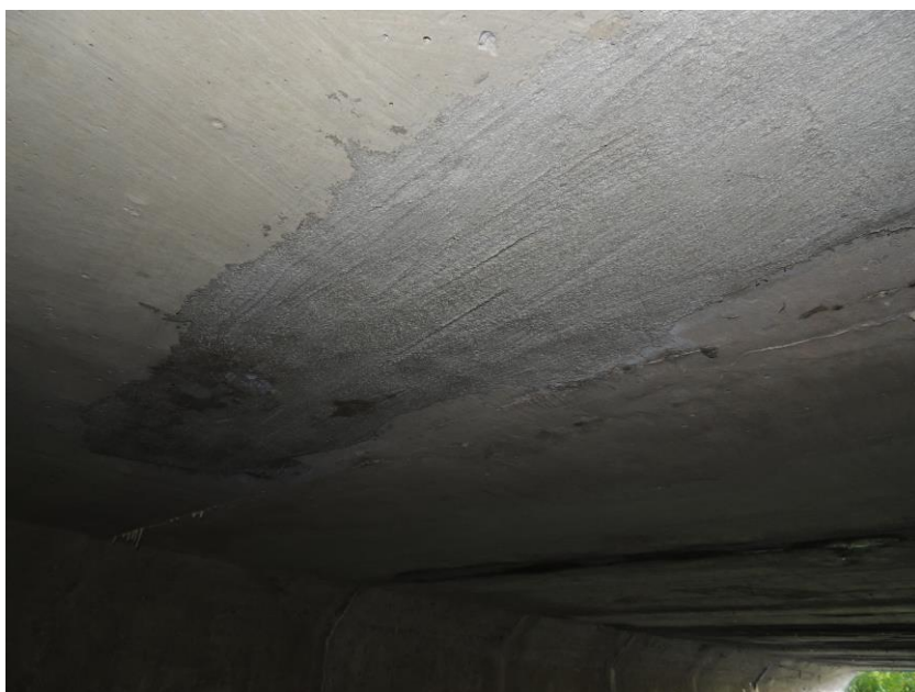
Původní výsrava stropních částí prefabrikátů
