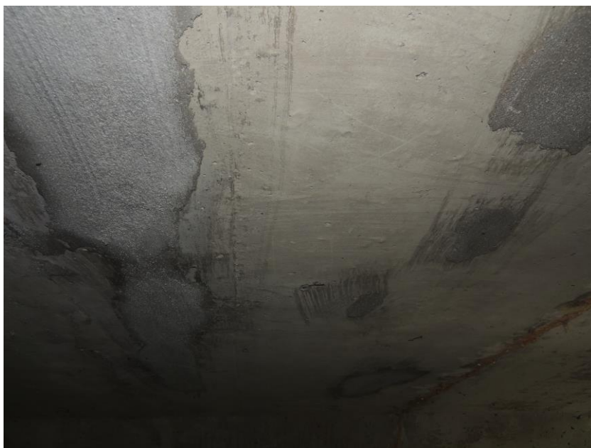
Původní výspravy stropních částí prefabrikovaných rámu mostu
