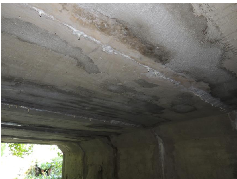
Původní výsrava stropních částí prefabrikátů a vápenné inkrustace na povrchu stykové spáry mezi prefabrikáty
