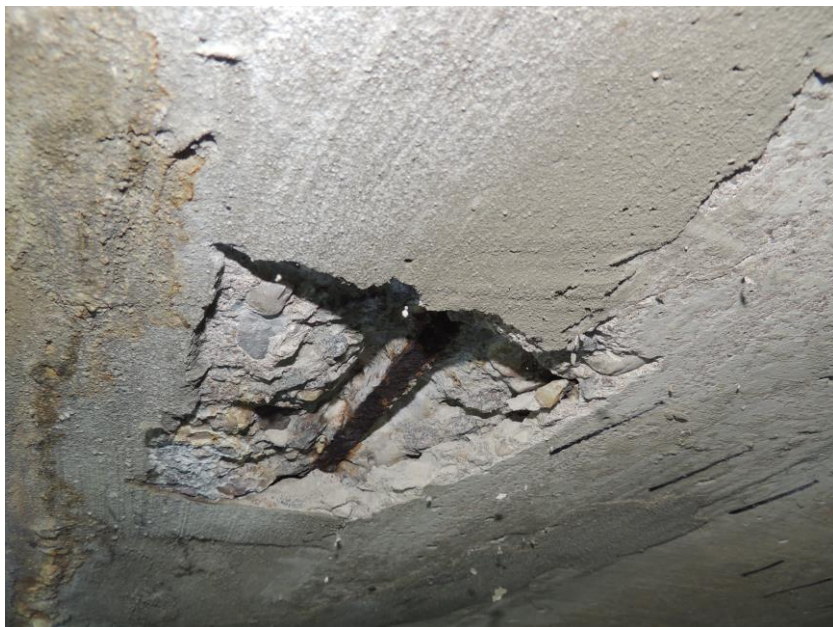
Sonda pro ověření pohledových charakteristik a průměru výztuže
