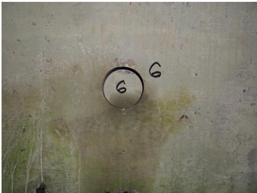
Místo odběru vzorku číslo 6 pro stanovení pevnosti betonu prefabrikátu
